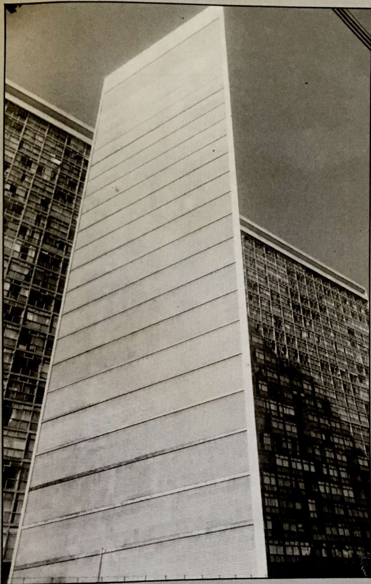
"CJK": torre de elevadores e escadas do bloco A (veja nas fotos 15 e 16 detalhes do interior da torre).
