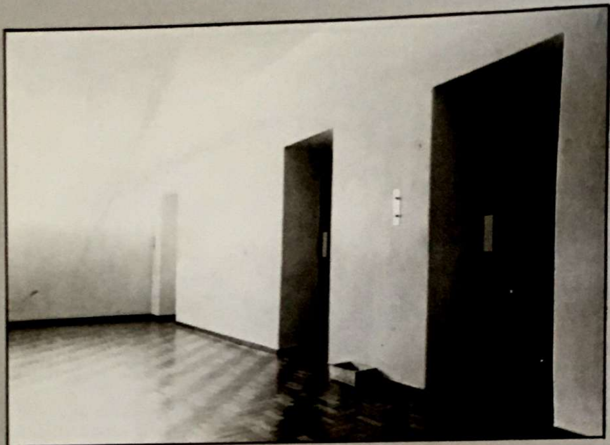
"CJK": hall de elevadores do Bloco B, em andar-padrão.
