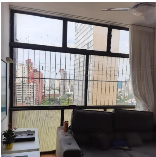
Janela em metalon original com grade, tipo 1 e tipo 2, bloco “A”. Fotografia: João Vitor Avelin, 2021.
