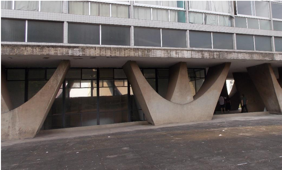
Espaço do Museu de Arte Moderna no primeiro pavimento do Bloco "A". Fonte: Teodoro Magni, DPCA, 2021.
