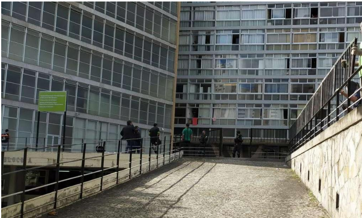
Bloco “A”: acesso ao segundo pavimento, destinado a Museu de Arte Moderna”. Fonte: Jornal Otempo, 2018.
