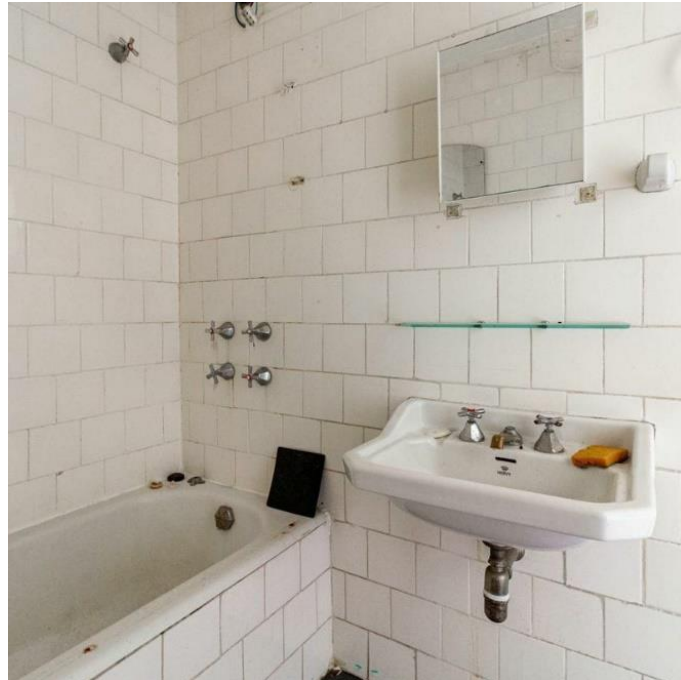
Banheiro apartamento tipo A. azulejos e louças originais Autoria: não identificada.
