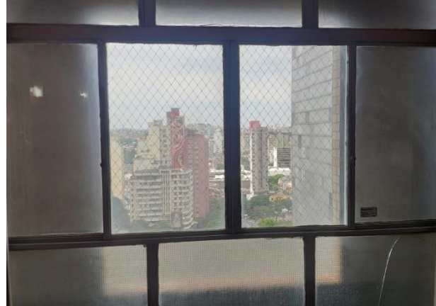
Janela original em metalon, do tipo 2, instalada atrás da fita horizontal do bloco “A”. Fotografia: Sergio Hirle de Souza, 2021.
