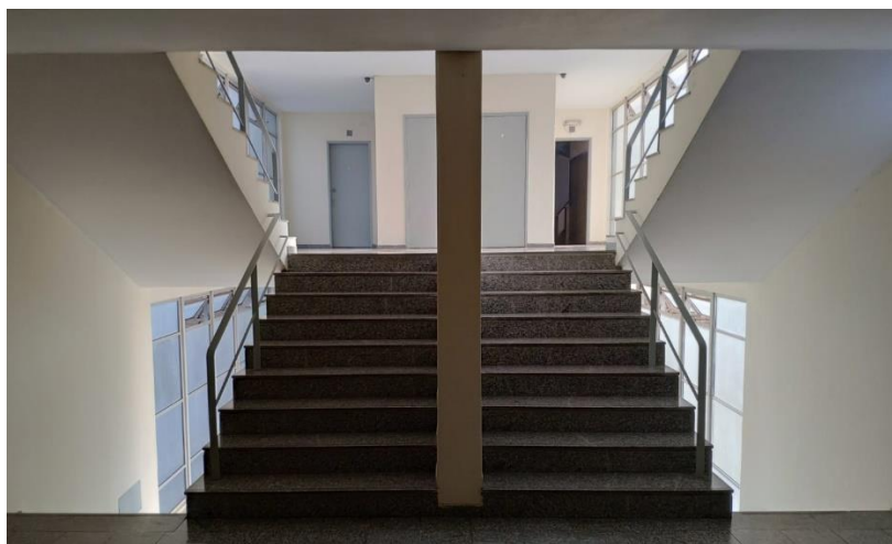
Escadas de ligação dos pavimentos dos apartamentos do bloco "A" com o nível intermediário bloco dos elevadores. Fotografia: Sergio Hirle de Souza, 2021.
