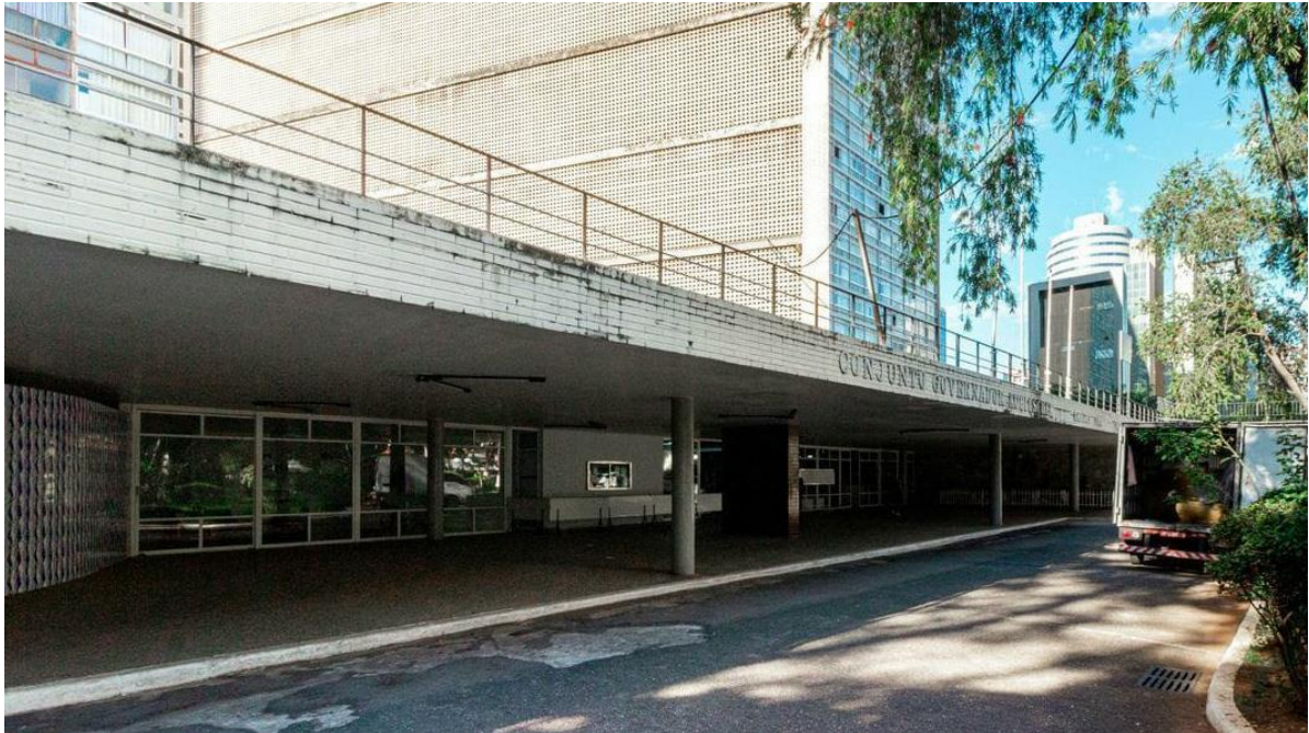
Hall de entrada do Bloco "A" na Rua dos Timbiras. Autoria: Não identificada.
