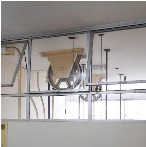
À esquerda, roldanas do elevador que podem ser vistas no décimo pavimento do Bloco “B”. À direita, elevador no hall principal do Bloco “B” para acesso às antigas repartições. Fotografia: Teodoro Magni, DPCA, 2021.
