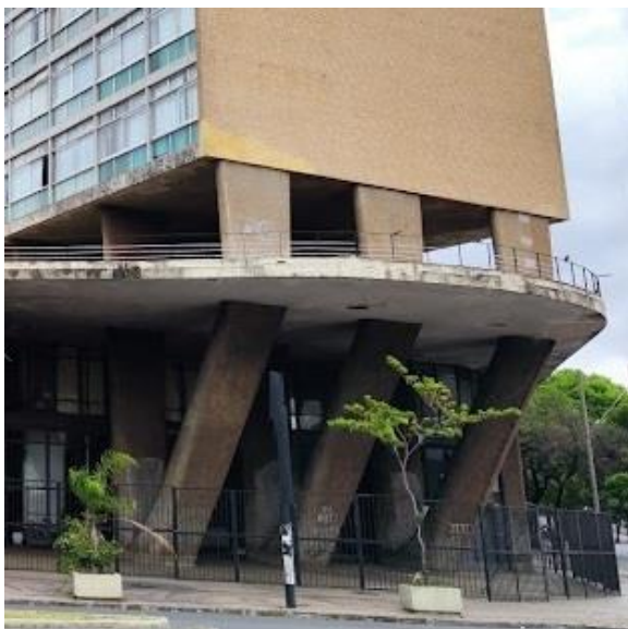
Pilares em “V” do Bloco “B” e fechamentos irregulares em grade. Fotografia: DPCA, 2019.
