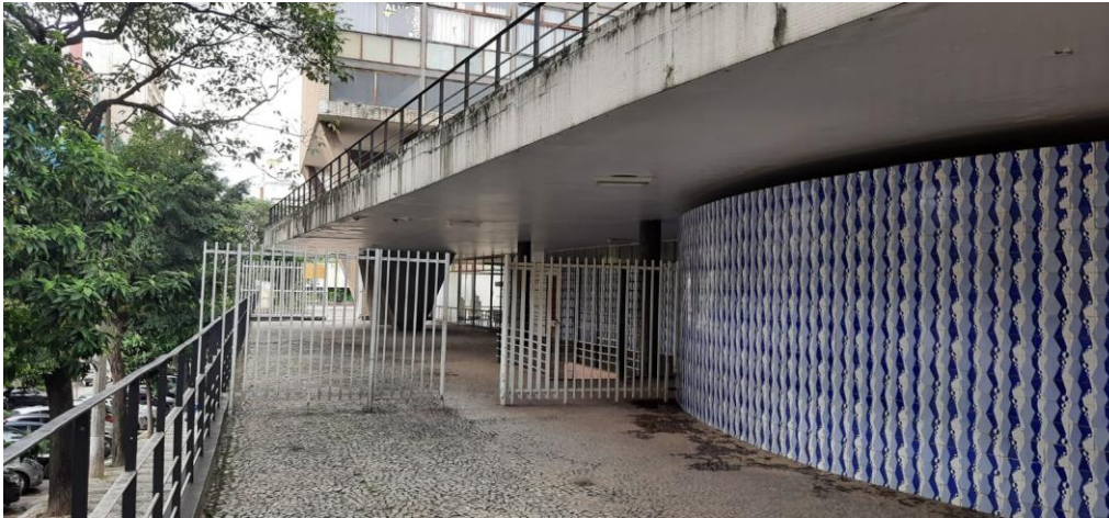
Primeiro Pavimento do Bloco “A”, no alinhamento com Rua Rio Grande do Sul, abaixo do segundo pavimento onde se encontra o espaço previsto para o Museu de Arte Moderna. Fotografia: Teodoro Magni. DPCA, 2021.
