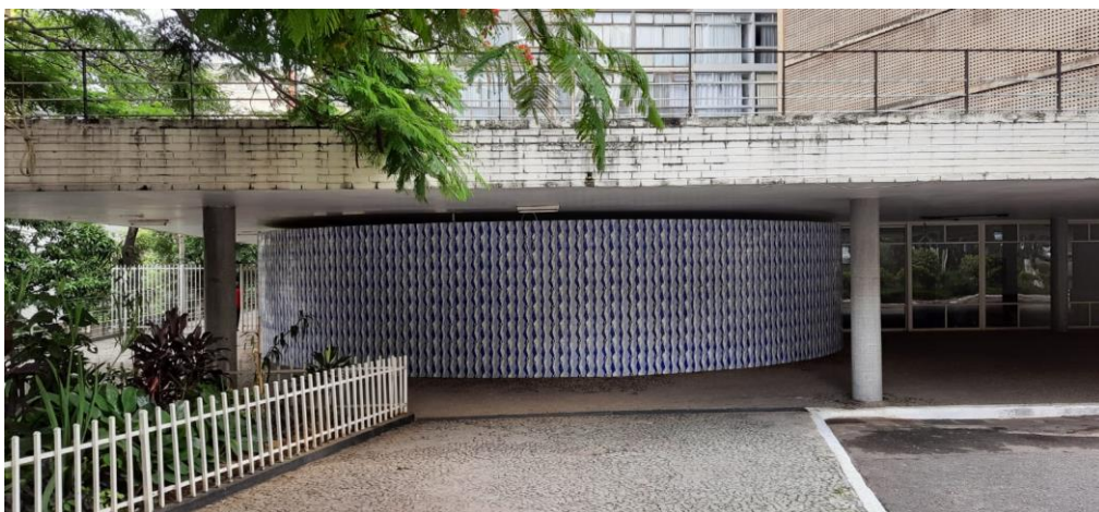
Rampa do ingresso ao Bloco “A” pela Rua dos Timbiras. Fotografia: Teodoro Magni. DPCA, 2021.
