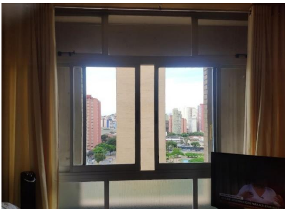
Janela em alumínio, do tipo 2, que substituiu a original em metalon, instalada atrás da fita horizontal do bloco “A”. Fotografia: Sergio Hirle de Souza, 2021.
