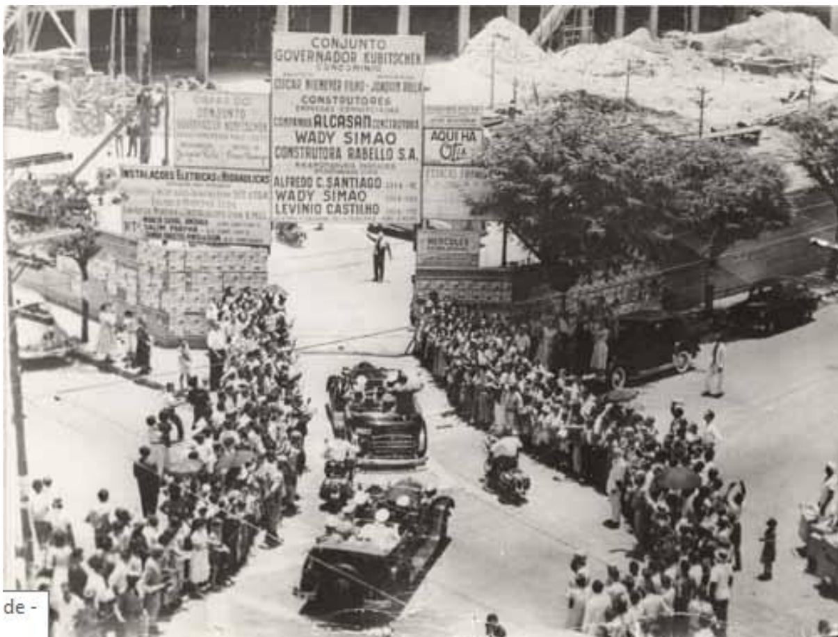
de - Visita de autoridades ao canteiro de obras do Condomínio Governador Kubitschke, no qual se vê placa contendo o expediente com nome dos construtores envolvidos no longo processo de construção do Condomínio.
