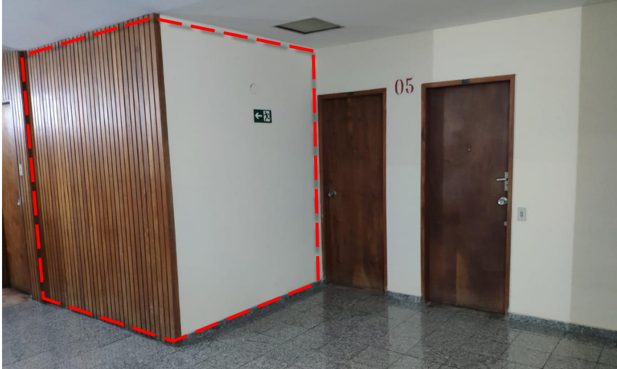
Bloco "A": demarcação do volume não previsto em projeto, que se repete em todos os pavimentos de apartamentos destinado possivelmente para abrigar as tubulações verticais de ventilação. Fotografia: Sergio Hirle de Souza, 2021.
