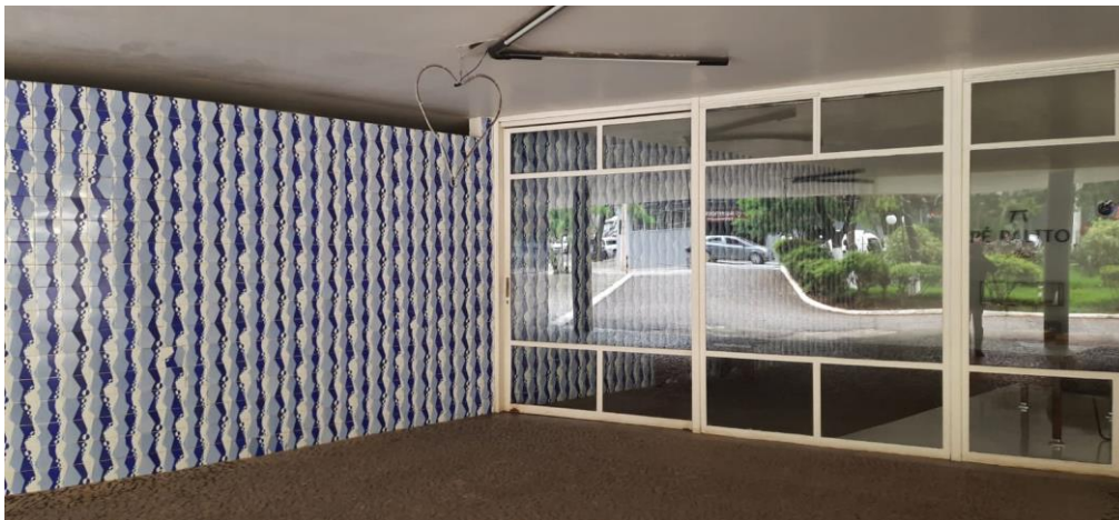
Primeiro Pavimento do Bloco "A". do hall de entrada. Fotografia: Teodoro Magni. DPCA, 2021.
