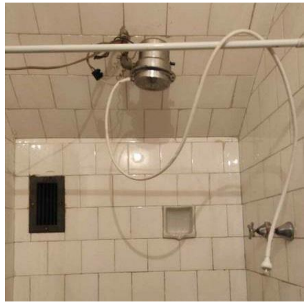
Cozinha apartamento tipo A e banheiro apartamento Tipo B. Notar o teto do banheiro inclinado em razão de se situar sob a escada de acesso ao semiduplex. Notar o azulejo 15 X15 cm, assentado com juntas desencontradas. Autoria: não identificada.
