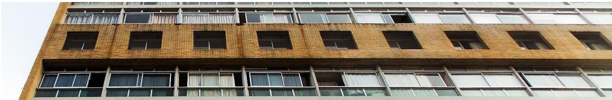
Janelas alteradas na fita horizontal. O tipo J1 original foi substituído pelo tipo J2. Flávia A. Miranda, DPCA, 2021.
