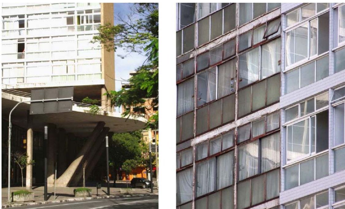
Figura 20: Pilares fazem transição em “V” na chegada ao solo.
