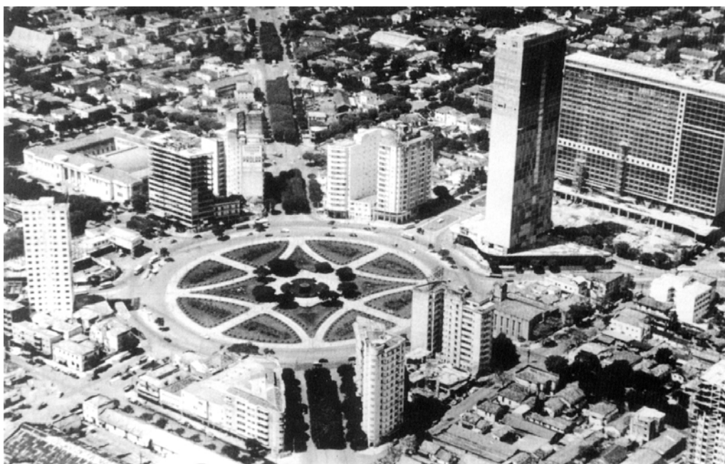
Figura 9: Vista aérea do conjunto JK em construção
